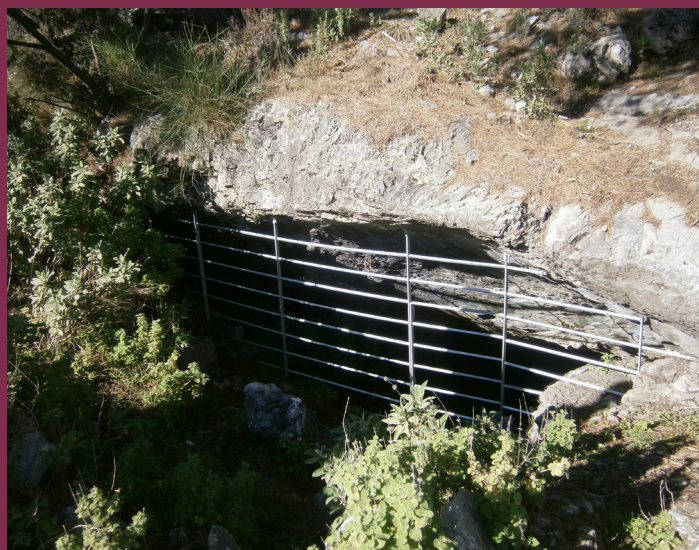
Entrada de cueva protegida mediante cerramiento adecuado para el paso de murciélagos, Cueva del Agua (Canillas de Albaida)
